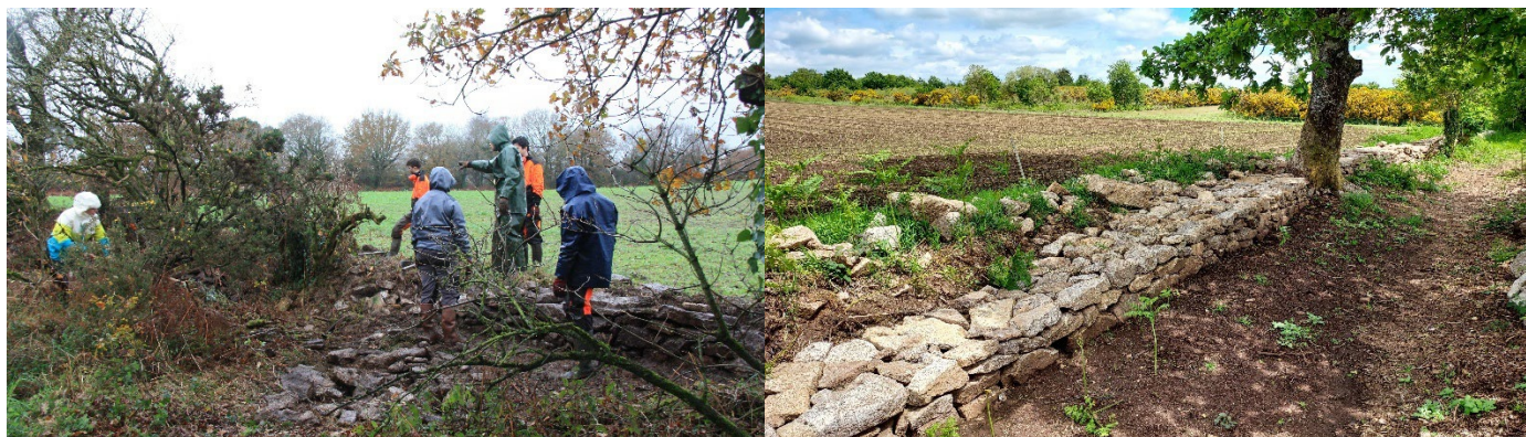
Figure 26. Restauration des murets de pierres présents sur les Landes du Crano
