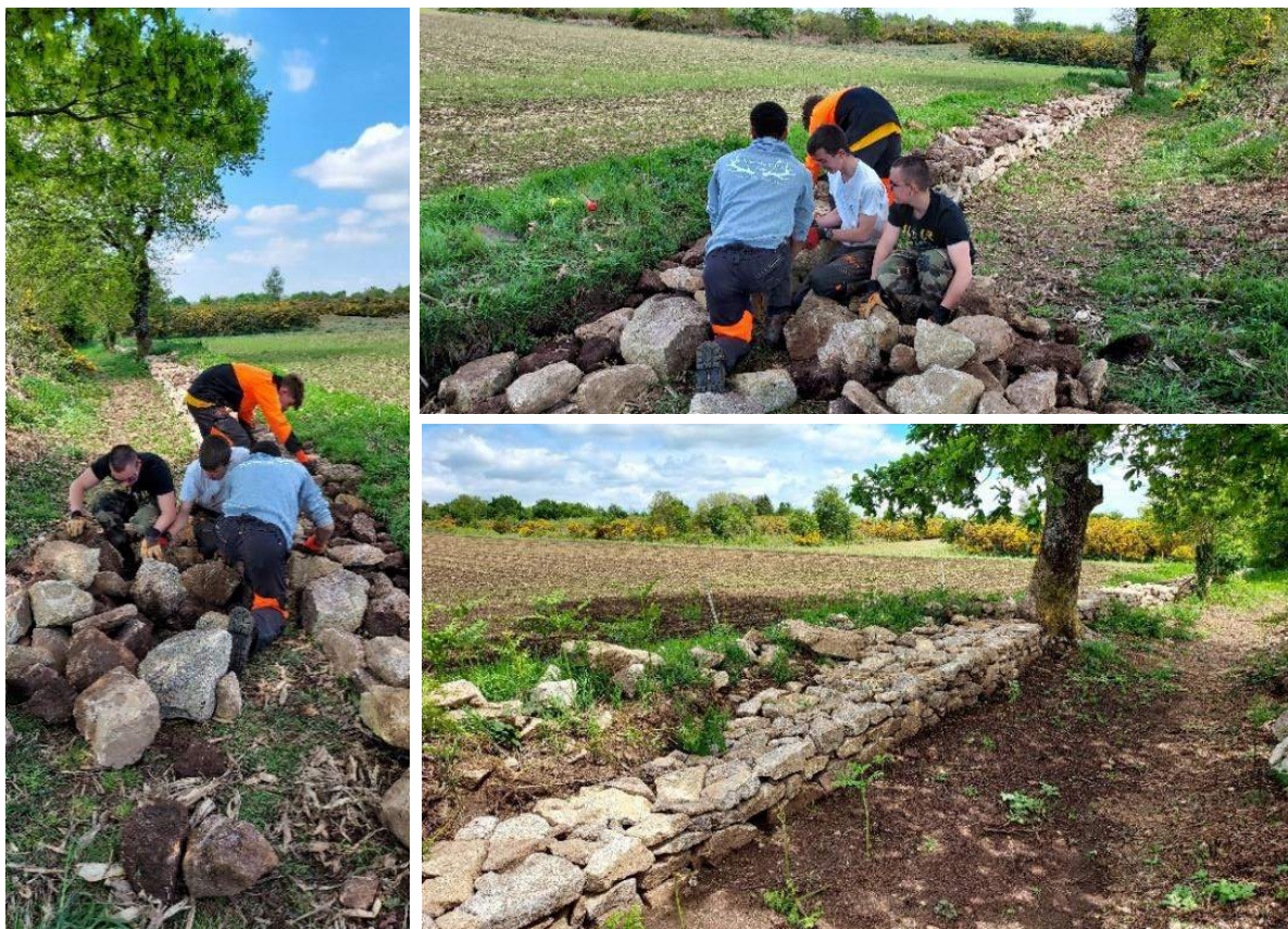
Restauration d'un muret en partenariat avec les étudiants du Lycée Anne de Bretagne
